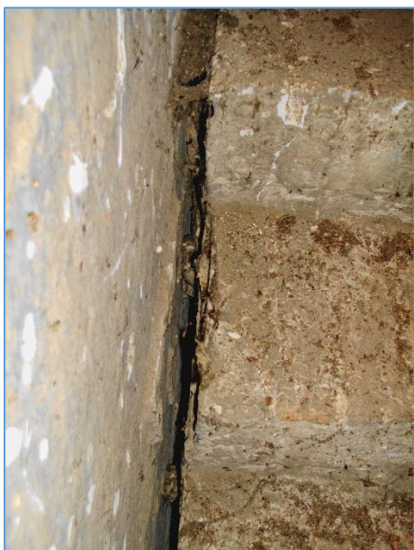
Obr.č. 35 – ODKLON STĚNY OD SCHODIŠTĚ 5 CM
