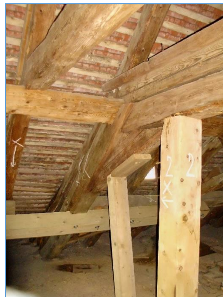
Obr.č. 8 – PROZATIMNÍ PODPŮRNÉ KCE BEZ TOHOTO OPATŘENÍ BY JIŽ PRAVDĚPODOBŇ DOŠLO K HAVÁRII KROVOVÉ SOUSTAVY
