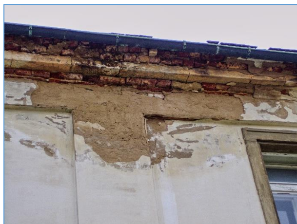
Obr.č. 46 – HAVARIJNÍ STAV ŘÍMSY
