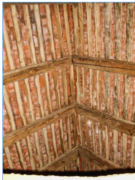
Obr.č. 44 – KROKVE V HŘEBENI SPOJENÉ „NA OSTŘIH“ – ZAHNILÉ SPOJE INDEX D
