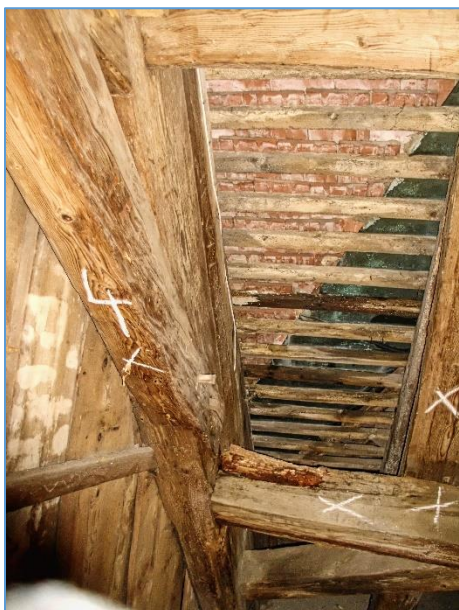
Obr.č. 17 – USMÝKNUTÁ DOLNÍ VAZNICE PV 4 – INDEX D
