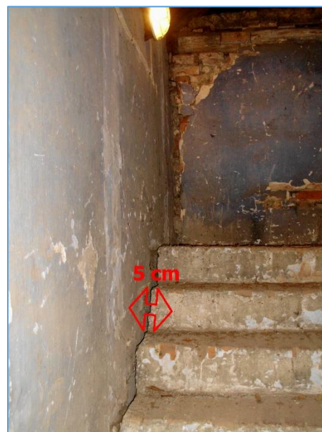
Obr.č. 34 – ODKLON STĚNY OD SCHODIŠTĚ 5 CM
