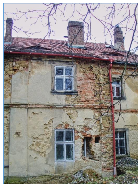
Obr.č. 48 – HAVARIJNÍ STAV SCHODIŠTNÍHO PŘÍSTAVKU
