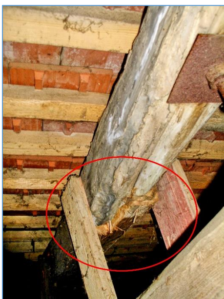
Obr.č. 3 – PROVIZORNÍ OPRAVA KROKVE INDEX D HROZÍ ÚSMÝKNUTÍ
