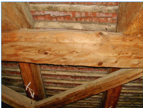
Obr.č. 43 – ČTYŘBOKÉ STŘEDOVÉ VAZNICE JE MOŽNÉ PO MECH. A CHEM. SANACI OPĚTOVNĚ POUŽÍT INDEX B
