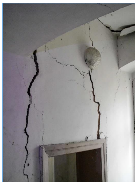
Obr.č. 32 – SILNÉ TRHLINY NA SCHODIŠTI (PŘÍSTAVEK) POD PV11
