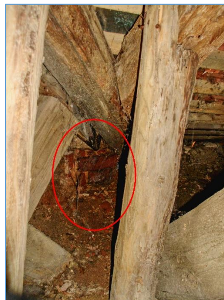
Obr.č. 2 – HAVARIJNÍ ROZPAD KONSTR.UZLE ÚŽLABÍ (U PV1) INDEX D - ODBĚR VZORKU VZ1
