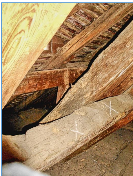
Obr.č. 19 – PRŮBĚŽNÁ DEGRADACE DOLNÍ VAZNICE - INDEX D
