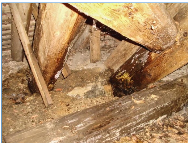
Obr.č. 39 – HAVARIJNÍ BIOTICKÁ DESTRUKCE PATNÍ ČÁSTI PV15 INDEX D ODBĚR VZORKU VZ9
