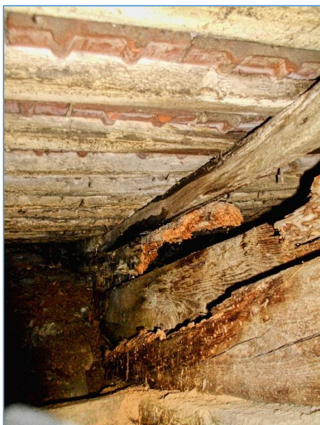
Obr.č. 13 – TOTÁLNÍ DEGRADACE PATY PV3 - INDEX D ODBĚR VZOKU VZ3
