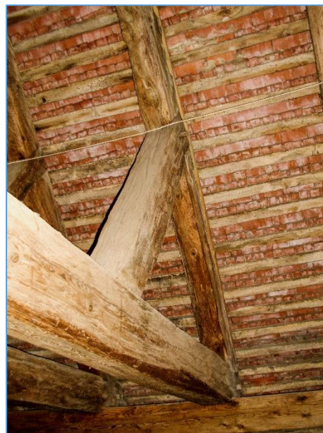
Obr.č. 42 – SVISLÉ VZPĚRY JE MOŽNÉ PO MECH. A CHEM. SANACI OPĚTOVNĚ POUŽÍT INDEX B
