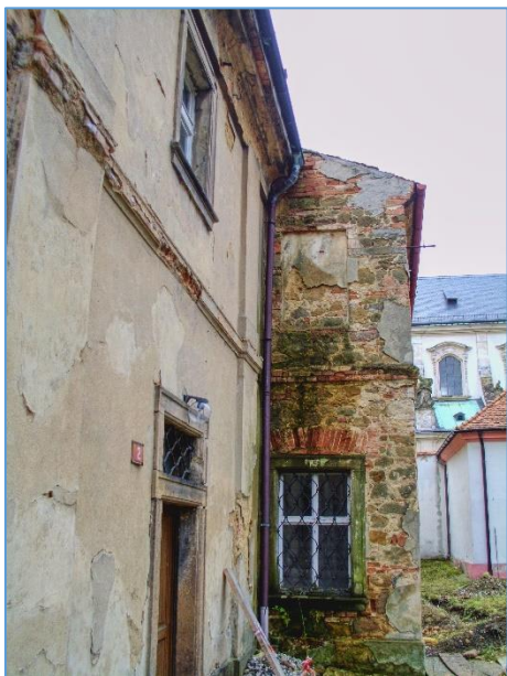
Obr.č. 49 – HAVARIJNÍ STAV SCHODIŠTNÍHO PŘÍSTAVKU
