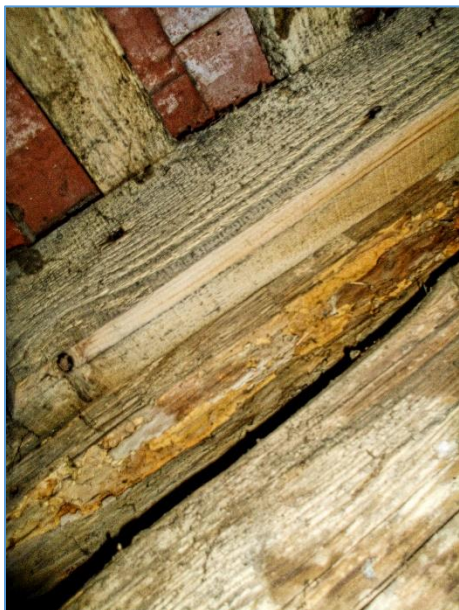
Obr.č. 5 – TOTÁLNÍ DESTRUKCE KROKVE LARVAMI DŘ. HMYZU (U PV1) INDEX D
