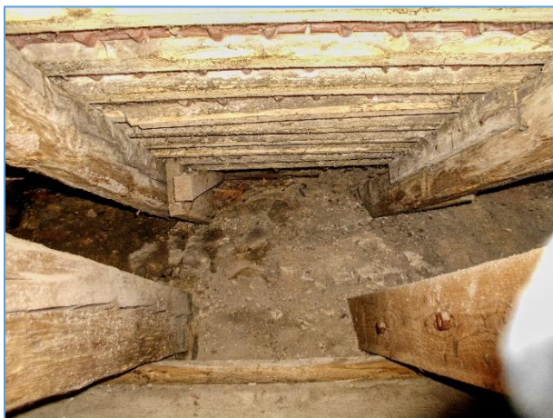
Obr.č. 21 – BIOTICKÁ DESTRUKCE PAT KROKVÍ A NÁMĚTKŮ INDEX D
