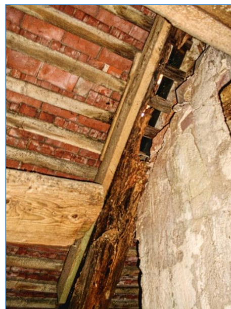
Obr.č. 40 – TOTÁLNÍ ROZPAD DŘEVNÍ HMOTY KROKVÍ V OBLASTI KOMÍNOVÝCH TĚLES – INDEX D
