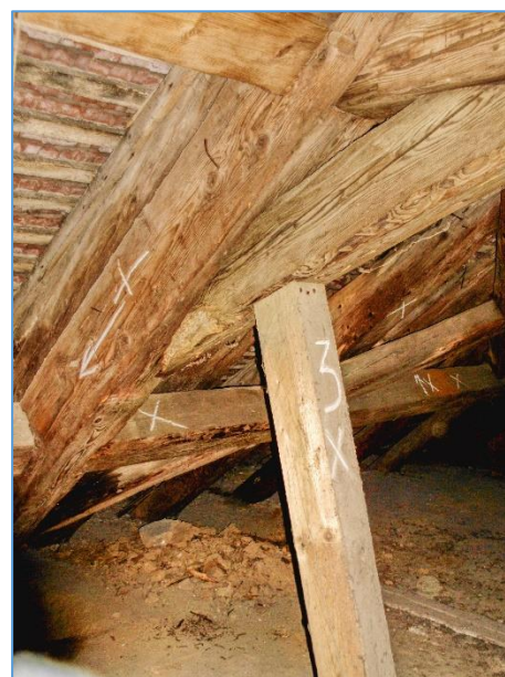
Obr.č. 12 – DETAIL BIOTICKÉ DESTRUKCE PV 3 - INDEX D
