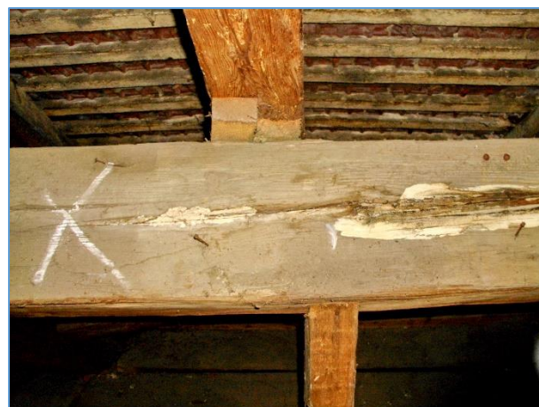
Obr.č. 20 – PLODNICE NA DOLNÍ VAZNICI ODBĚR VZORKU VZ5
