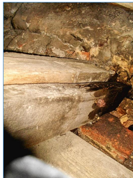
Obr.č. 22 – BIOTICKÁ DESTRUKCE PAT KROKVÍ A NÁMĚTKŮ INDEX D – ODBĚR VZORKU VZ6
