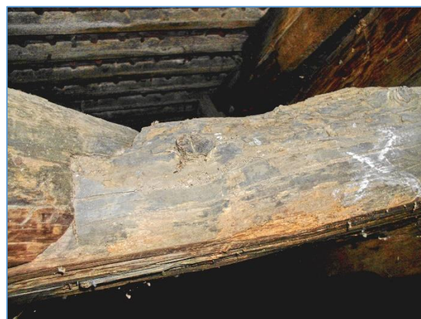
Obr.č. 24 – BIOTICKÁ DEGRADACE DOLNÍ VAZNICE PV9 INDEX D
