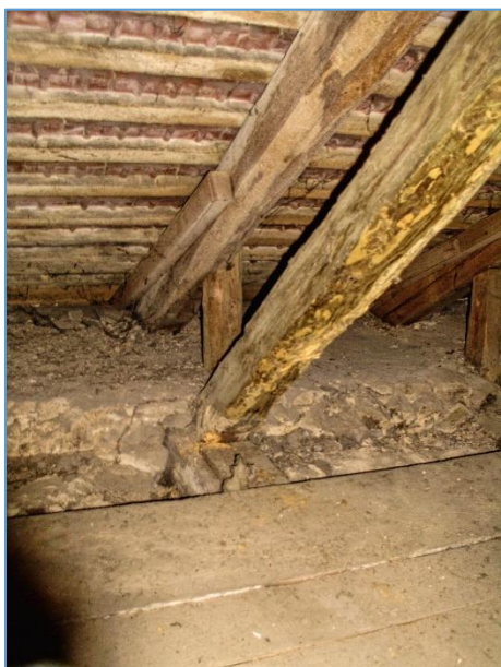
Obr.č. 23 – DESTRUKČNĚ NAPADENÁ BĚLOVÁ ČÁST KROKVE LARVAMI DŘ. HMYZU
