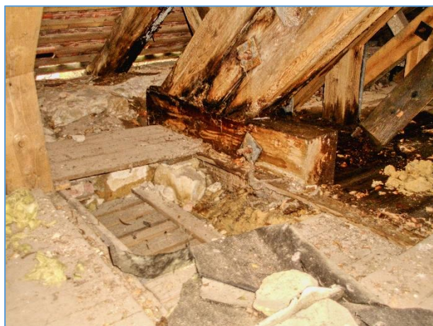
Obr.č. 27 – HAVARIJNÍ STAV PATY PV 10 INDEX D ODBĚR VZORKU VZ7
