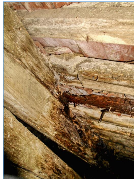
Obr.č. 10 – TOTÁLNÍ DEGRADACE KROKVÍ PO CELÉM OBVODU BUDOVY HORNÍ HRANA KR ZAHNILÁ NAD 1/3 PROFILU PRVKU INDEX D
