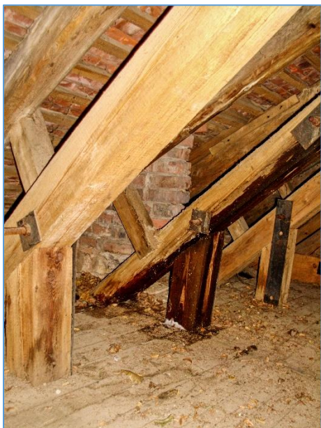
Obr.č. 29 – HAVARIJNÍ STAV JIŽ NOVĚ VLOŽENÝCH KCÍ MEZI PV10-11 – INDEX D
