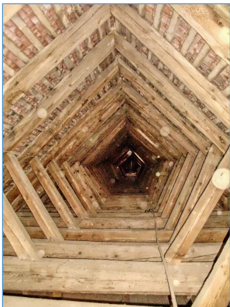
Obr.č. 41 – POHLED DO HORNÍ ČÁSTI KROVU SVISLÉ VZPĚRY JE MOŽNÉ PO MECH. A CHEM. SANACI OPĚTOVNĚ POUŽÍT INDEX B
