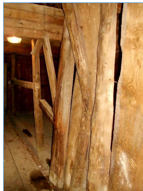
Obr.č. 36 – TLAKEM ZDEFORMOVANÉ PODPĚRY PV 14
