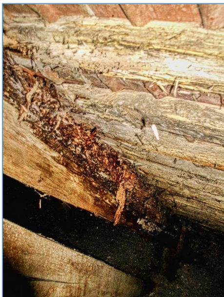
Obr.č. 7 – TOTÁLNÍ DEGRADACE KROKVÍ PO CELÉM OBVODU BUDOVY HORNÍ HRANA KR ZAHNILÁ NAD 1/3 PROFILU PRVKU INDEX D
