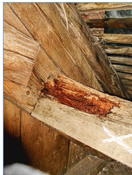
Obr.č. 18 – DETAIL DOLNÍ VAZNICE PV4 ODBĚR VZORKU VZ4 - INDEX D
