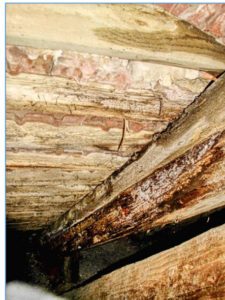
Obr.č. 6 – TOTÁLNÍ DEGRADACE KROKVÍ PO CELÉM OBVODU BUDOVY HORNÍ HRANA KR ZAHNILÁ DO 2-3 CM INDEX D
