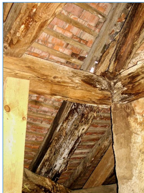
Obr.č. 30 – HAVARIJNÍ BIOTICKÁ DESTRUKCE PV11 INDEX D ODBĚR VZORKU VZ8
