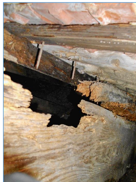
Obr.č. 14 – TOTÁLNÍ DEGRADACE PV3 - INDEX D
