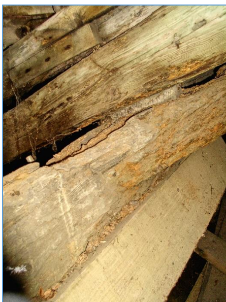
Obr.č. 11 – TOTÁLNÍ DEGRADACE DOLNÍ VAZNICE PO CELÉM OBVODU BUDOVY INDEX D ODBĚR VZORKU VZ2
